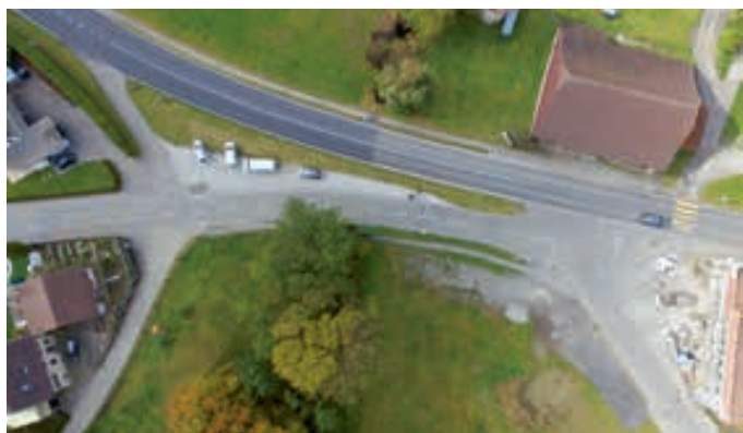
Situation avant travaux
