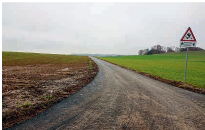
Route du Trimbié après réfection
