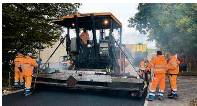
Pose du revêtement
